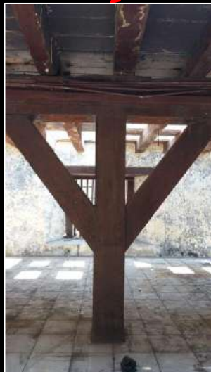
KONDIDI EXISTING : KOLOM LANTAI 1 TIDAK MENERUS KE LANTAI 2
