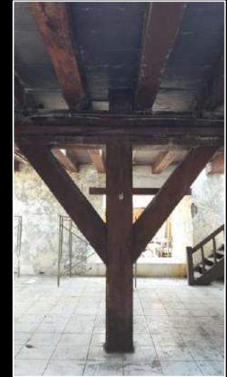
KONDIDI EXISTING : KOLOM LANTAI 1 TIDAK MENERUS KE LANTAI 2
