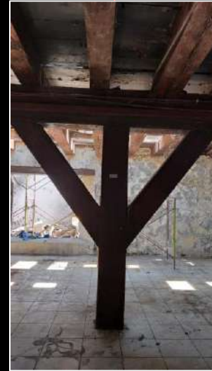
KONDIDI EXISTING : KOLOM LANTAI 1 TIDAK MENERUS KE LANTAI 2
