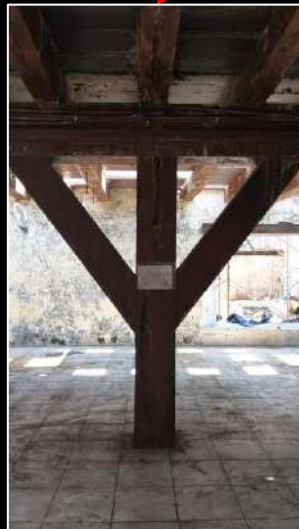
KONDIDI EXISTING : KOLOM LANTAI 1 TIDAK MENERUS KE LANTAI 2
