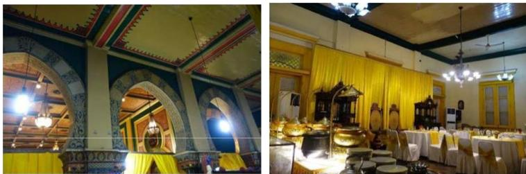
Dudukan balok pada Istana Maimun ada yang tipe (a) – kiri, langsung menempuh pada dinding dan tipe (c) – kanan, menempuh pada balok keliling.
