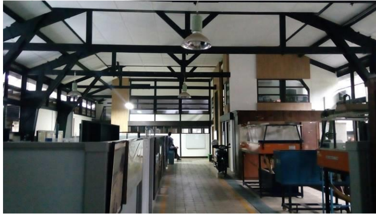
Gambar 3.3.7. Tampak kuda – kuda, plafond, lantai, dan partisi Laboratorium Mekanika Fluida tahun 2012.
