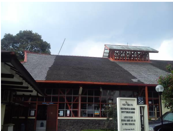
Gambar 3.3.14. Atap sirap Laboratorium Hidraulika tahun 2016.
