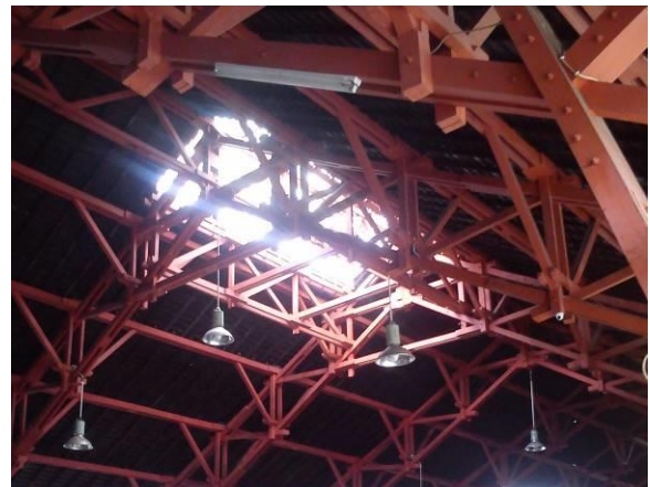
Gambar 3.3.15. Skylight dari kaca tempered Laboratorium Hidraulika tahun 2016.
