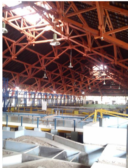
Gambar 3.3.19. Kuda - kuda Laboratorium Hidraulika tahun 2016.
